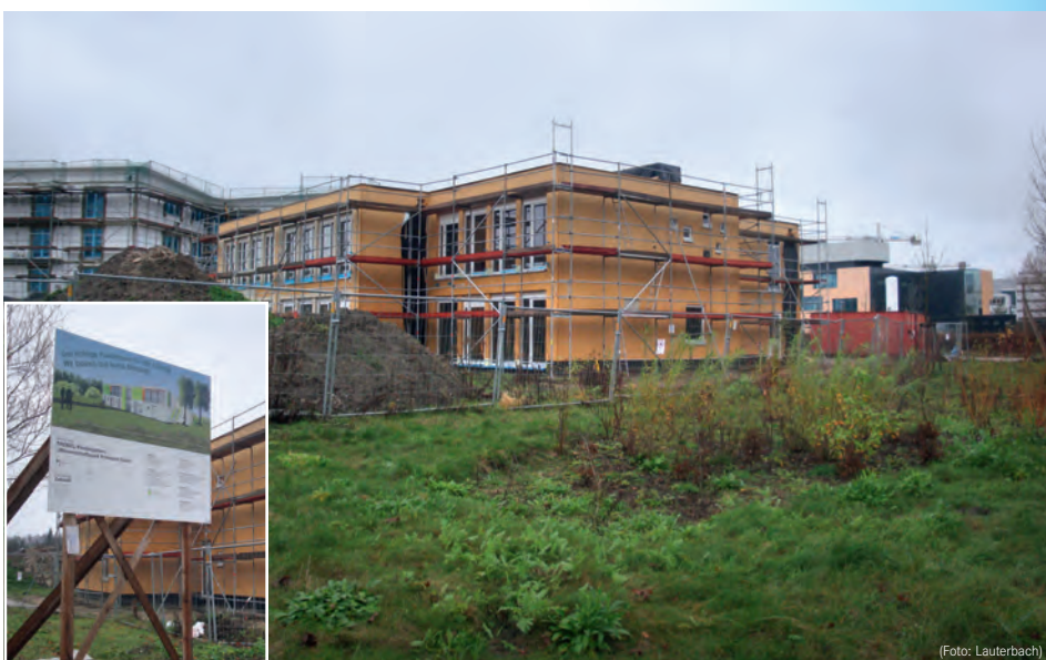
Der Bau der neuen Kita ist winterfest
