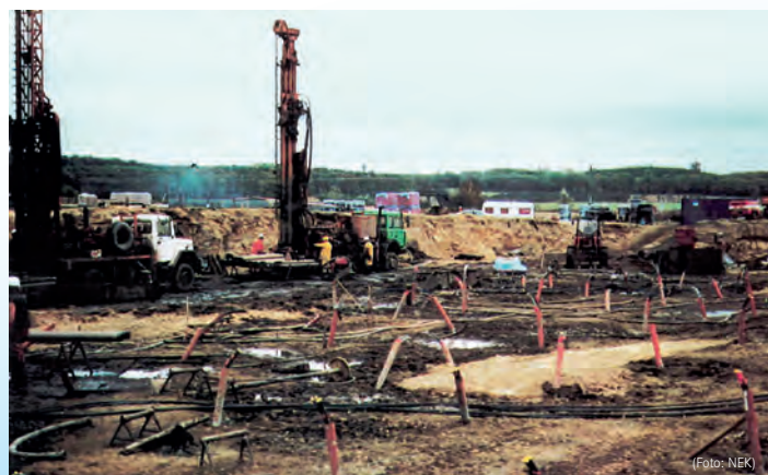
Erschließung des Sondenfeldes in der Bauphase (1998)
